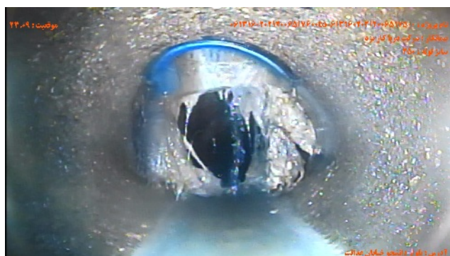
شماره تصویر ۳ عنوان اتصال جانبی معيوب / اتصال معيوب انشعاب موقعیت ۲۳۰۹ کد CX
