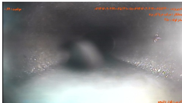
شماره تصویر ۲ عنوان تراز آب / تراز آب کدر موقییت ۰.۹۹ کد WLT درصد ۵
