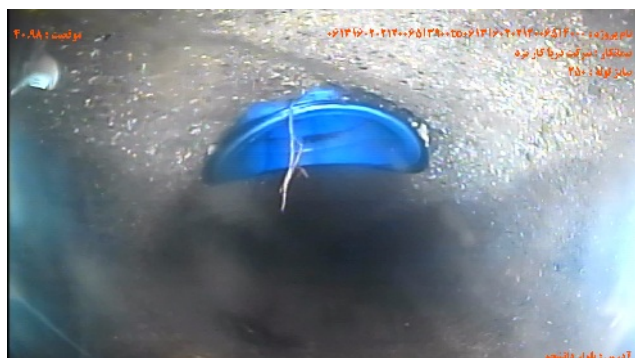
شماره تصویر ۵ عنوان اتصال جانبی معيوب / اتصال معيوب اشعاب موقعیت ۴۰۹۸ کد CX
