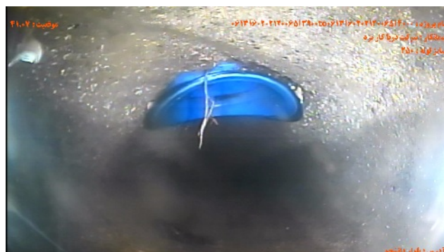
شماره تصویر ۶ عنوان نفوذ ریشه / نفوذ ریشه نازک موقعیت ۴۱۰۷ کد RF
