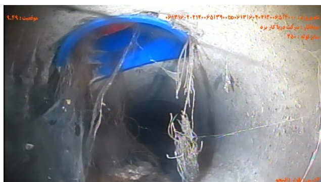
شماره تصویر ۳ عنوان اتصال جانبی معيوب / اتصال معيوب اشعاب موقعیت ۹۰۴۹ کد CX
