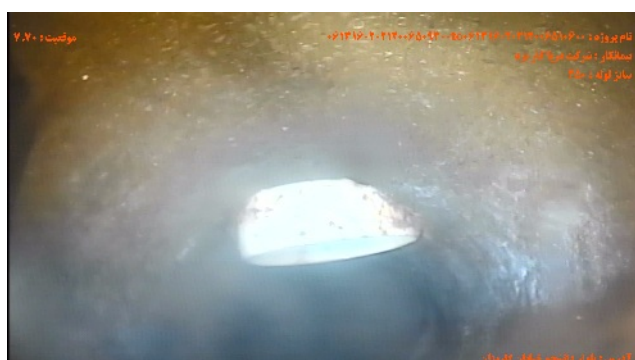
شماره تصویر ۳ عنوان اتصال جانبی معيوب / اتصال معيوب اشعاب موقعیت ۷۰۷۰ کد CX
