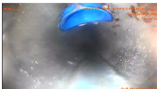
شماره تصویر ۴ عنوان اتصال جانبی معيوب / اتصال معيوب اشعاب موقعیت ۲۴۰۷۶ کد CX
