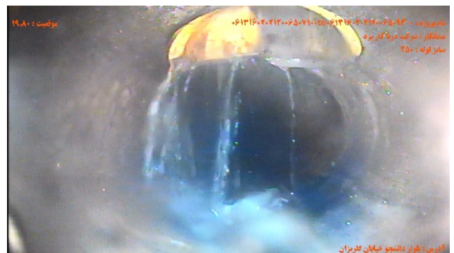
شماره تصویر ۴ عنوان موقیعت ۱۹۰۰ کد محل اتصال اشعب/اتصال اشعب CN
