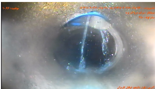
شماره تصویر ۳ عنوان موقیعت ۱۰۰۲۶ کد محل اتصال اشعب/اتصال اشعب CN
