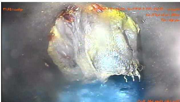
شماره تصویر ۵ عنوان موقیعت ۲۱۰۶۵ کد اتصال جانبی معيوب/اتصال معيوب اشعب CX
