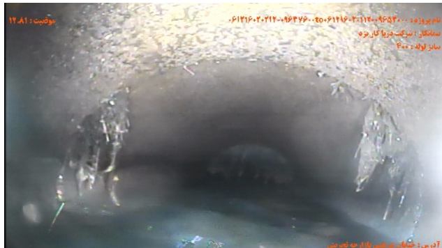
شماره تصویر ۱۳ موقیبت ۱۲.۸۱ کد RF عنوان نفوذ ریشه/نفوذ ریشه نازک
