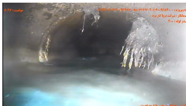
شماره تصویر ۶ عنوان موقیعت ۶۰۴۶ کد نفوذ ریشه / نفوذ آبوه ریشه ها و گاهی سطح مقطع به میزان % RM ۲۰ درصد
