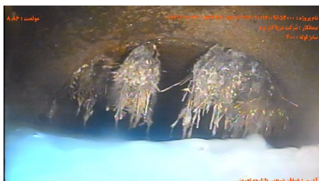
شماره تصویر ۱۱ موقیعت ۸.۸۶ کد RM عنوان نفوذ ریشه/ نفوذ آبوه ریشه ها و کاهنی سطح مقطع به میزان % درصد ۳۰
