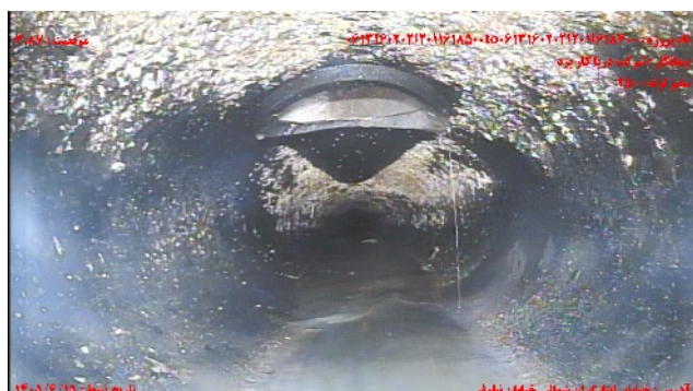
شماره تصویر ۳ عنوان محل اتصال انشعاب / اتصال انشعاب موقعیت ۳۰۸۷ کد CN
