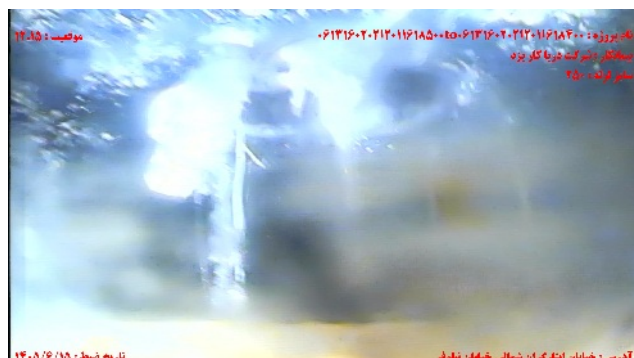
شماره تصویر ۶ عنوان نفوذ ریشه / نفوذ ریشه نازک موقعیت ۱۲.۱۵ کد RF
