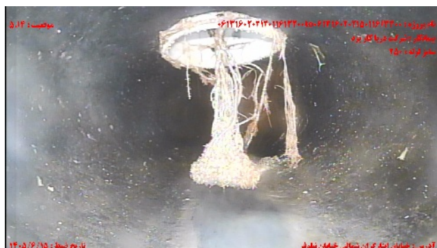
شماره تصویر ۵ عنوان موقیعت ۵۱۴ کد RM نفوذ ریشه / نفوذ انبوه ریشه ها و کاهنی سطح مقطع به میزان ۱۰ درصد
