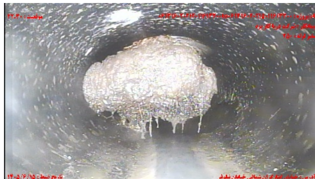
شماره تصویر ۸ عنوان اتصال جانبی معيوب/اتصال معيوب انشعاب موقعیت ۲۲.۳۰ کد CX
