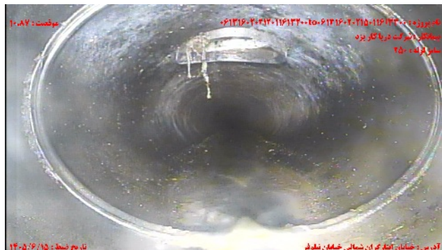
شماره تصویر ۷ عنوان اتصال جانبی معيوب/اتصال معيوب انشعاب موقعیت ۱۰.۸۷ کد CX
