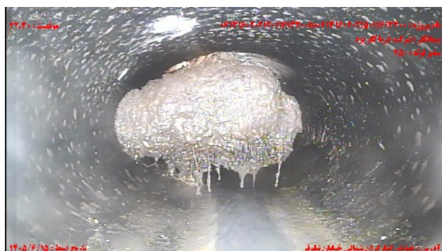
شماره تصویر ۹ عنوان نفوذ ریشه / نفوذ آبوه ریشه ها و کاهشی سطح مقطع به میزان ۴۰ درصد موقعیت ۲۲.۳۰ کد RM
