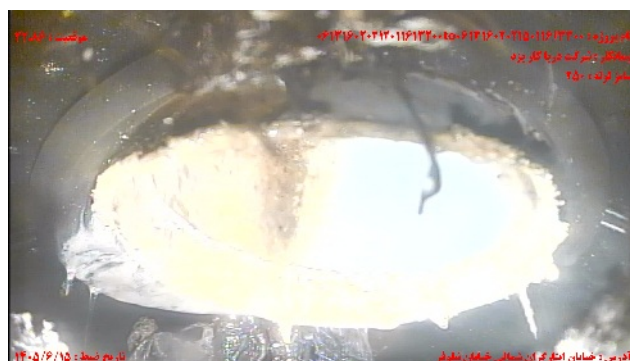
شماره تصویر ۱۰ عنوان اتصال جانبی معيوب/اتصال معيوب انشعاب موقعیت ۲۲.۸۶ کد CX
