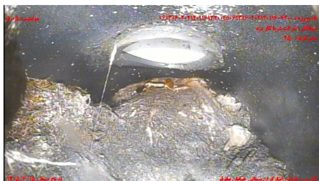
شماره تصویر ۳ عنوان اتصال جانبی معيوب / اتصال معيوب انشعاب موقعیت ۵۰۵ کد CX
