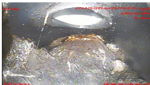
شماره تصویر ۴ عنوان اتصال جانبی معيوب / اتصال معيوب انشعاب موقعیت ۵۰۸ کد CX
