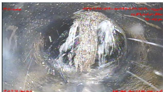
شماره تصویر ۱۱ موقیعت ۳۲.۱۱ کد RM عنوان نفوذ ریشه / نفوذ انبوه ریشه ها و کاهشی سطح مقطع به میزان ۱۰ درصد
