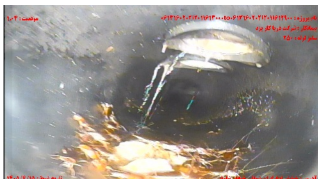
شماره تصویر ۳ عنوان موقعیت ۱۰۴ کد اتصال جانبی معيوب / اتصال معيوب اشعاب
