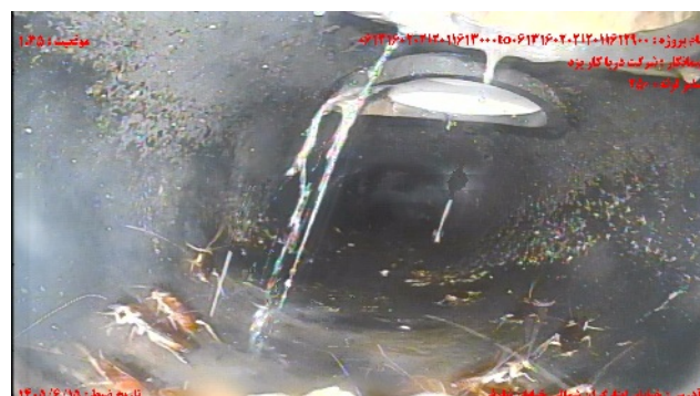
شماره تصویر ۴ عنوان موقعیت ۱۳۵ کد اتصال جانبی معيوب / اتصال معيوب اشعاب
