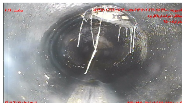
شماره تصویر ۶ عنوان موقعیت ۶۰۹ کد نفوذ ریشه / نفوذ ریشه نازک
