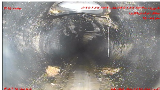
شماره تصویر ۸ موقیعت ۱۷.۹۵ کد RF عنوان نفوذ ریشه / نفوذ ریشه نازک
