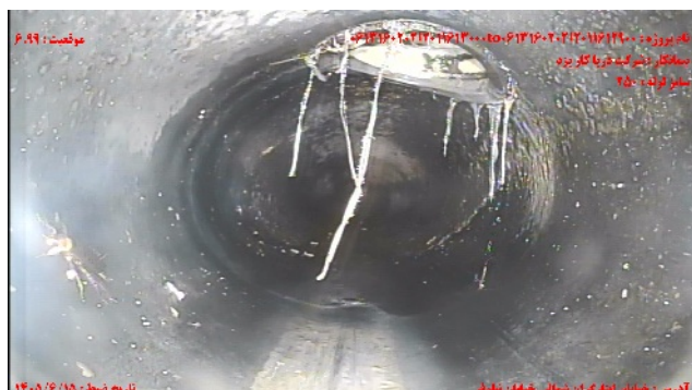
شماره تصویر ۵ عنوان موقعیت ۶۰۹ کد اتصال جانبی معيوب / اتصال معيوب اشعاب
