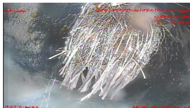
شماره تصویر ۶ عنوان نفوذ ریشه / نفوذ آبوه ریشه ها و گاهی سطح مقطع به میزان % موقعیت ۱۵.۹۰ کد RM درصد ۲۰
