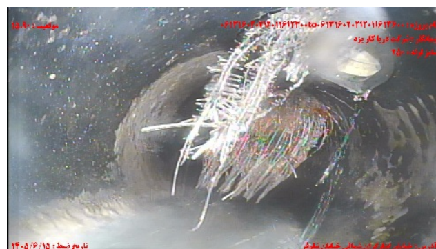
شماره تصویر ۴ عنوان نفوذ ریشه / نفوذ آبوه ریشه ها و گاهی سطح مقطع به میزان % موقعیت ۱۵.۹۰ کد RM درصد ۱۰
