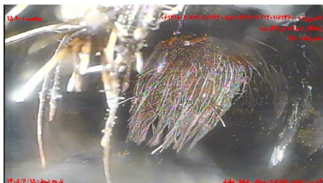
شماره تصویر ۵ عنوان اتصال جانبی معيوب / اتصال معيوب انشعاب موقعیت ۱۵.۹۰ کد CX
