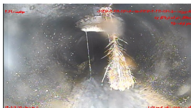
شماره تصویر ۴ عنوان موقعیت ۴۰۴۹ کد نفوذ ریشه / نفوذ آبوه ریشه ها و گاهی سطح مقطع به میزان % درصد ۱۰
