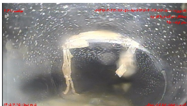
شماره تصویر ۳ عنوان اتصال باز / به میزان % قطر موقعیت ۴۰۳۱ کد OJ
