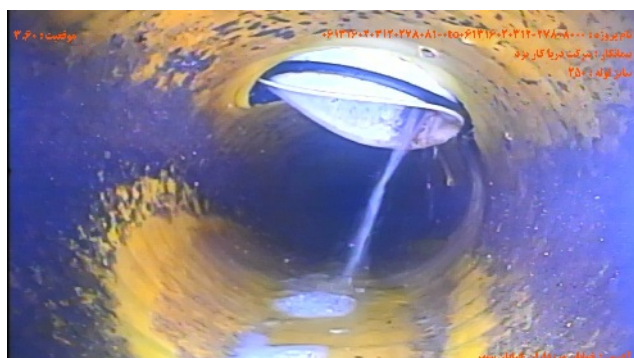
شماره تصویر ۳ عنوان اتصال جانبی معيوب / اتصال معيوب انشعاب موقعیت ۳۰۶۰ کد CX
