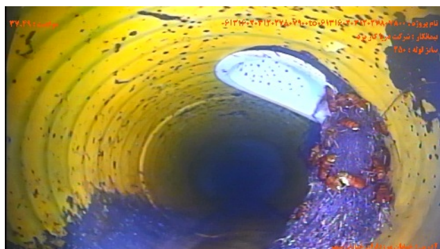
شماره تصویر ۵ عنوان موقعیت ۳۷.۴۹ کد اتصال جانبی معيوب / اتصال معيوب انشعاب CX
