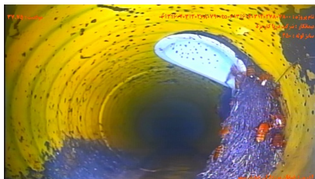
شماره تصویر ۶ عنوان موقعیت ۳۷.۷۵ کد نفوذ ریشه / نفوذ ابويه ریشه ها و گاهی سطح مقطع به میزان ۲۰ درصد RM
