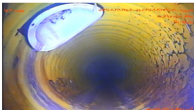
شماره تصویر ۵ عنوان محل اتصال انشعاب / اتصال انشعاب موقعیت ۱۸۰۲ کد CN
