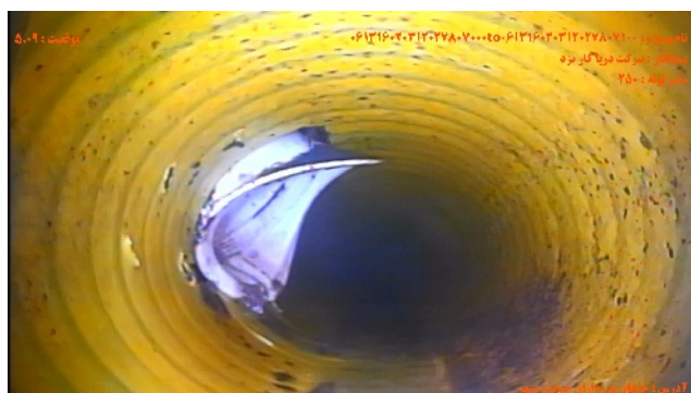
شماره تصویر ۳ عنوان اتصال جانبی معيوب / اتصال معيوب انشعاب موقعیت ۵۰۹ کد CX
