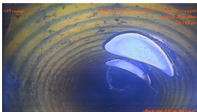
شماره تصویر ۳ عنوان موقعیت ۱.۴۲ کد محل اتصال انشعاب / اتصال انشعاب CN
