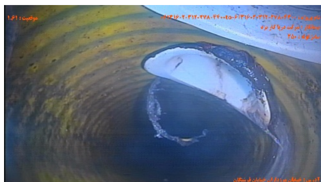
شماره تصویر ۴ عنوان موقعیت ۱.۶۱ کد محل اتصال انشعاب / اتصال انشعاب CN
