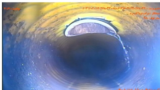
شماره تصویر ۶ عنوان موقعیت ۱۲.۶۱ کد CN محل اتصال انشعاب / اتصال انشعاب
