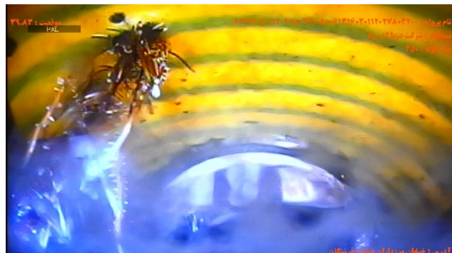
شماره تصویر ۸ عنوان سوراخ / سوراخ در دیواره فاضلاب موقعیت ۳۹.۸۳ کد H
