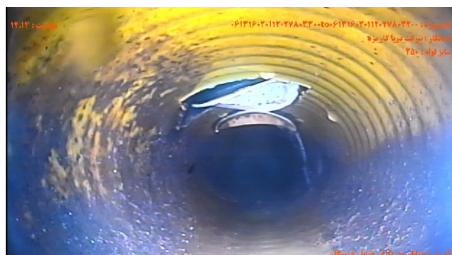
شماره تصویر ۴ عنوان موقعیت ۱۲.۱۴ کد CX اتصال جانبی معيوب / اتصال معيوب انشعاب
