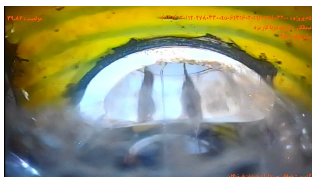
شماره تصویر ۱۰ عنوان اتصال جانبی معيوب / اتصال معيوب انشعاب موقعیت ۳۹.۸۳ کد CX
