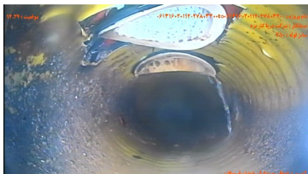
شماره تصویر ۵ عنوان موقعیت ۱۲.۲۹ کد CN محل اتصال انشعاب / اتصال انشعاب
