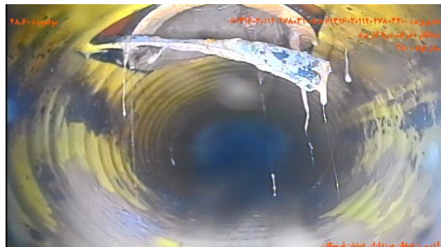
شماره تصویر ۸ عنوان اتصال جانبی معيوب / اتصال معيوب انشعاب موقعیت ۲۸.۶۰ کد CX
