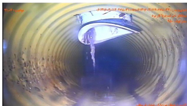
شماره تصویر ۶ عنوان اتصال جانبی معيوب / اتصال معيوب انشعاب موقعیت ۲۱۰۰۴ کد CX
