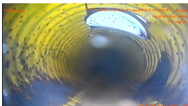
شماره تصویر ۱۱ عنوان نفوذ ریشه / نفوذ ریشه نازک موقعیت ۴۴.۵۲ کد RF
