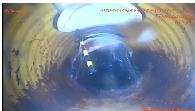
شماره تصویر ۴ عنوان محل اتصال انشعاب / اتصال انشعاب موقعیت ۱۴۰۴۵ کد CN
