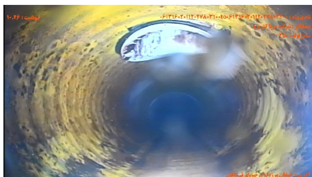
شماره تصویر ۳ عنوان محل اتصال انشعاب / اتصال انشعاب موقعیت ۱۰۰۲۶ کد CN
