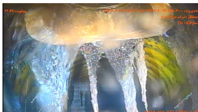
شماره تصویر ۱۰ عنوان نفوذ ریشه / نفوذ انبوه ریشه ها و گاهی سطح مقطع به میزان ۲۰ درصد موقعیت ۲۲.۳۹ کد RM
