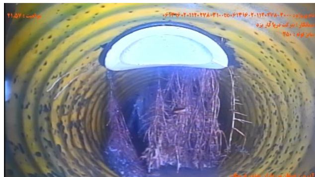
شماره تصویر ۸ عنوان نفوذ ریشه / نفوذ انبوه ریشه ها و گاهی سطح مقطع به میزان ۲۰ درصد موقعیت ۲۱.۵۷ کد RM
