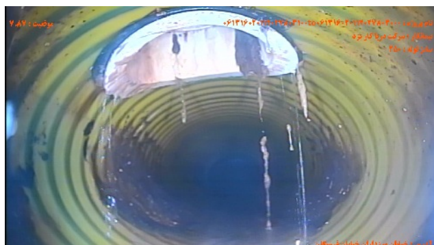
شماره تصویر ۵ عنوان موقیعت ۷۰۸۷ کد CN محل اتصال انشعاب / اتصال انشعاب
