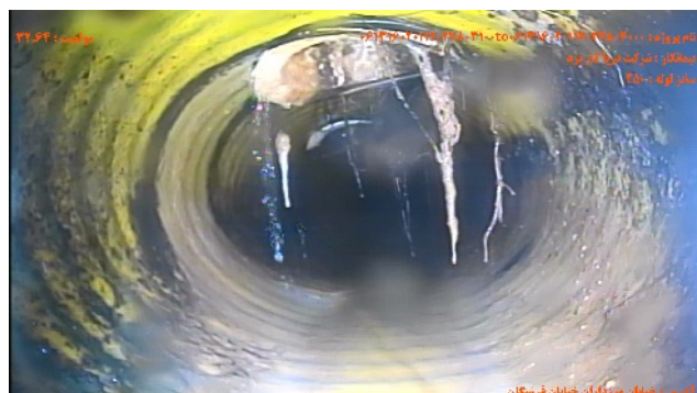
شماره تصویر ۱۲ عنوان نفوذ ریشه / نفوذ انبوه ریشه ها و گاهی سطح مقطع به میزان ۱۰ درصد موقعیت ۳۲.۶۴ کد RM
