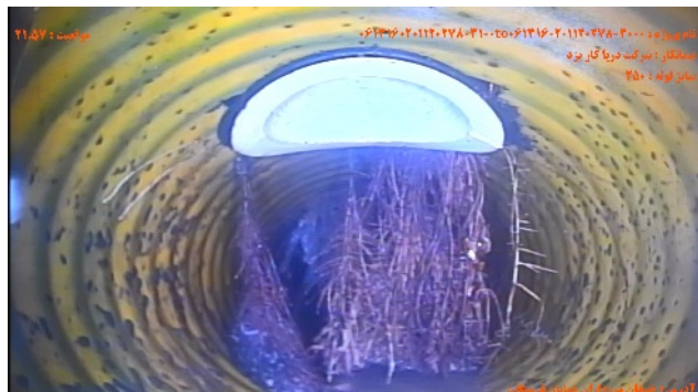
شماره تصویر ۷ عنوان اتصال جانبی معيوب / اتصال معيوب انشعاب موقعیت ۲۱.۵۷ کد CX
