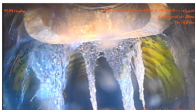
شماره تصویر ۹ عنوان اتصال جانبی معيوب / اتصال معيوب انشعاب موقعیت ۲۲.۳۹ کد CX
